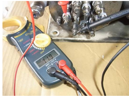
ヒーター導通確認
